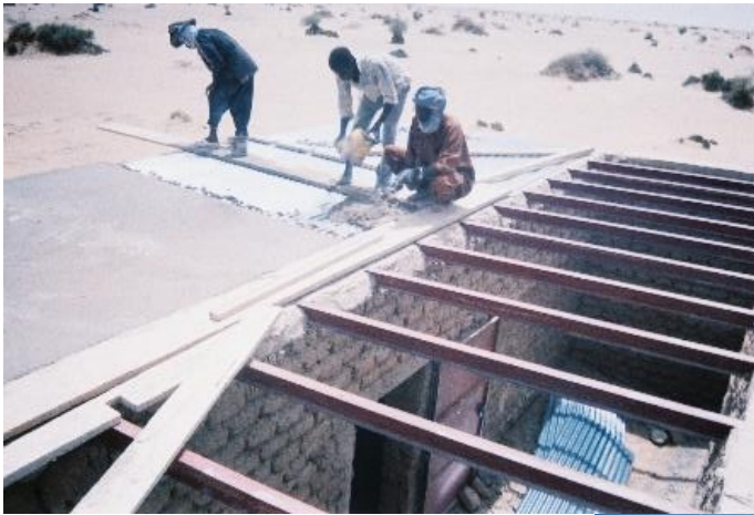
Pose des tôles ondulées + dalle en ciment
